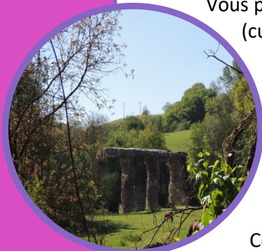
Pont siphon à Brignais
